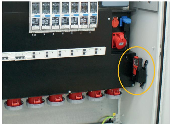
TorchLED Taschenlampe Notlicht in Baustromverteiler
